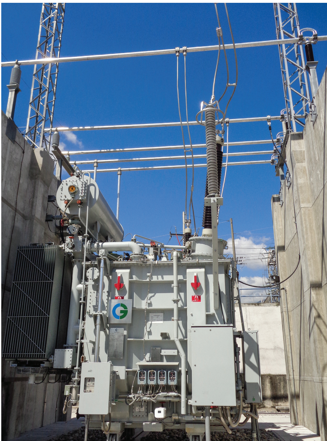
Ampliación Subestación Panaluya
