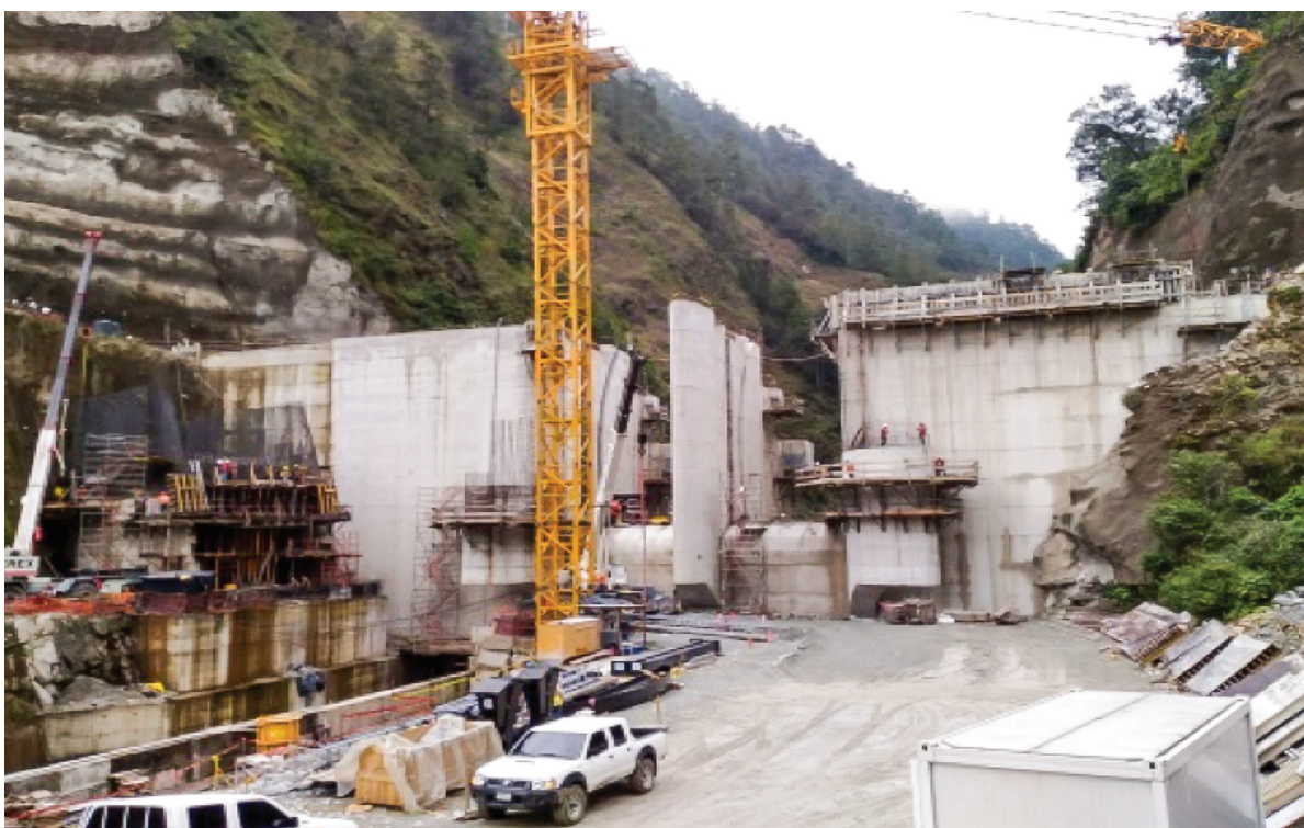
Construcción de Hidroeléctrica Xacbal Delta I.
